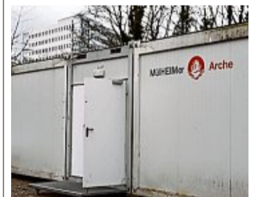
Die Containeranlage Mülheimer Arche
