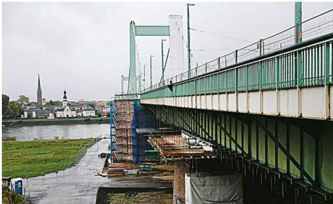
Mülheimer Brücke: Nach Arbeiten unter der Fahrbahn werden nun Leitungen erneuert. Foto: Banneyer
